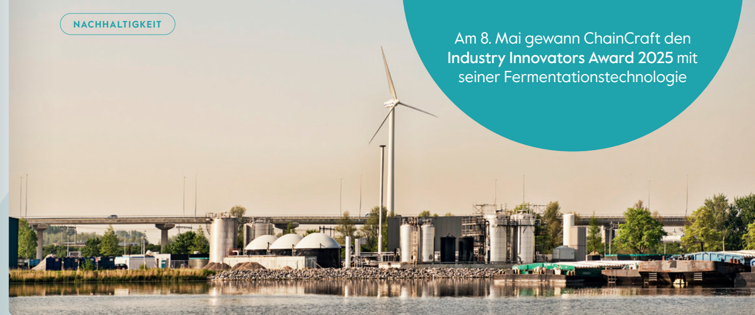
↑ Die Demonstrationsanlage von ChainCraft in Amsterdam
